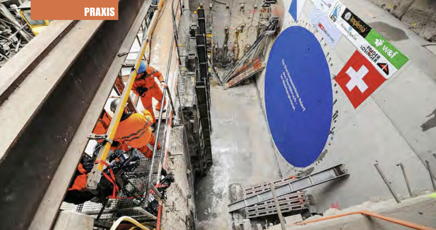
Bild oben: Der Weinbergtunnel kurz vor dem Durchschlag 2010. Beim letzten Teilstück der Durchmesserlinie vor dem Bahnhof in Zürich stellten Echtzeitmessungen sicher, dass umliegende Gebäude und Tunnels keinen Schaden nahmen.
