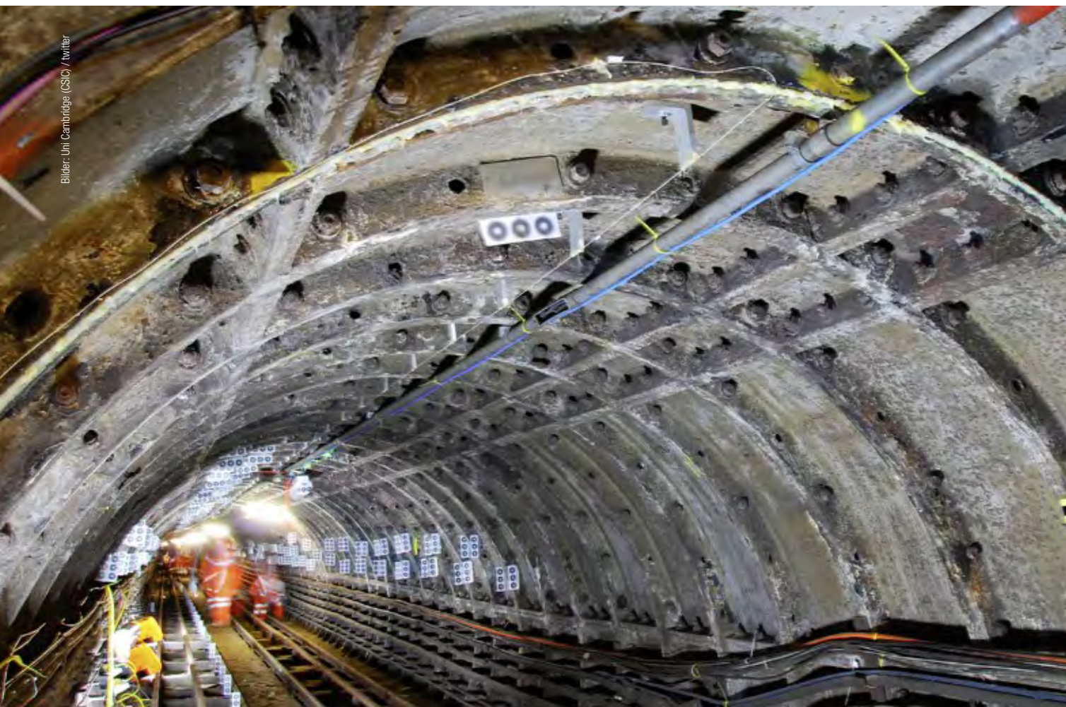
Diverse Sensoren, auch aus Glasfasern, wurden von den Wissenschaftlern im «Royal Mail»-Tunnel verlegt, um Bewegungen zu messen, welche die Tunnelbohrmaschine verursachen könnte.
